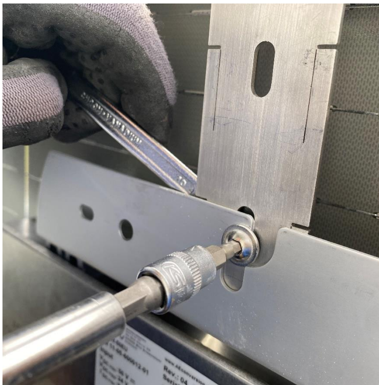
Abb. 6/Wechselrichter am SOLAR-HOOK Befestigungsbügel anschrauben
