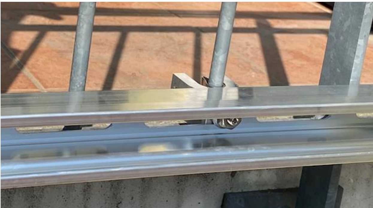
Abb.g 11/Montageschiene und Spezialklemme von außen
