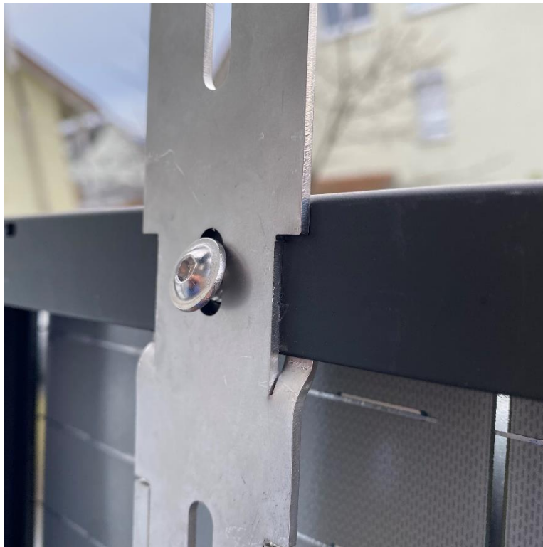
Abb. 5/locker angesetzte Schraube M6 kurz
