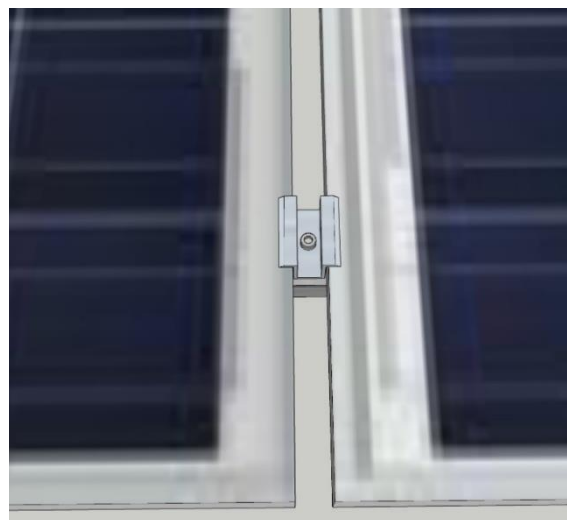
Abb. 12/Modulendklemme anbringen
