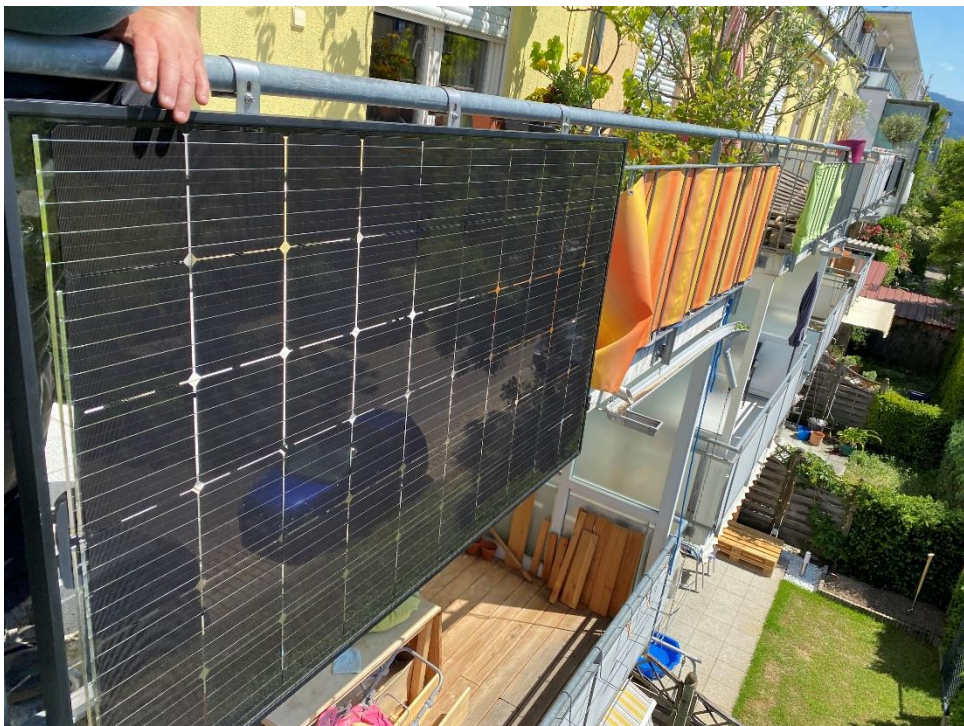
Abb. 18/Ansicht von außen
